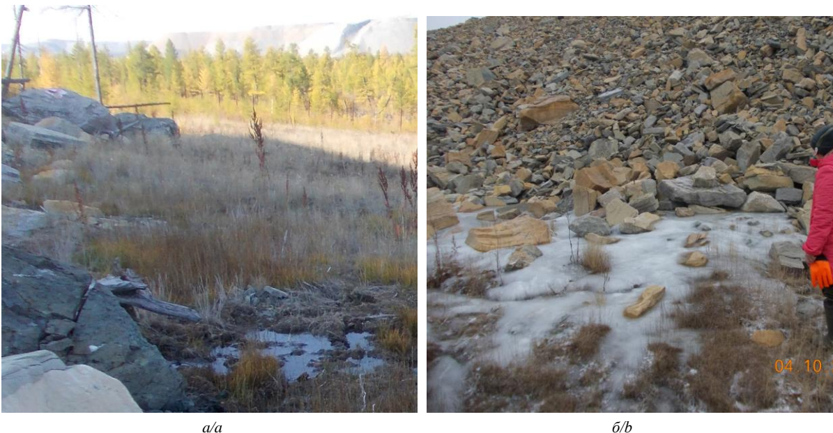
Рис. 12. Водные стоки, вытекающие из-под насыпи на эпицентре ПЯВ «Кристалл» в августе 2019 г. (а) и в октябре 2021 г. (б) Fig. 12. Water runoff under the artificial cover at the epicenter PUNE "Crystal" on August 2019 (a) and on October 2021 (b)
