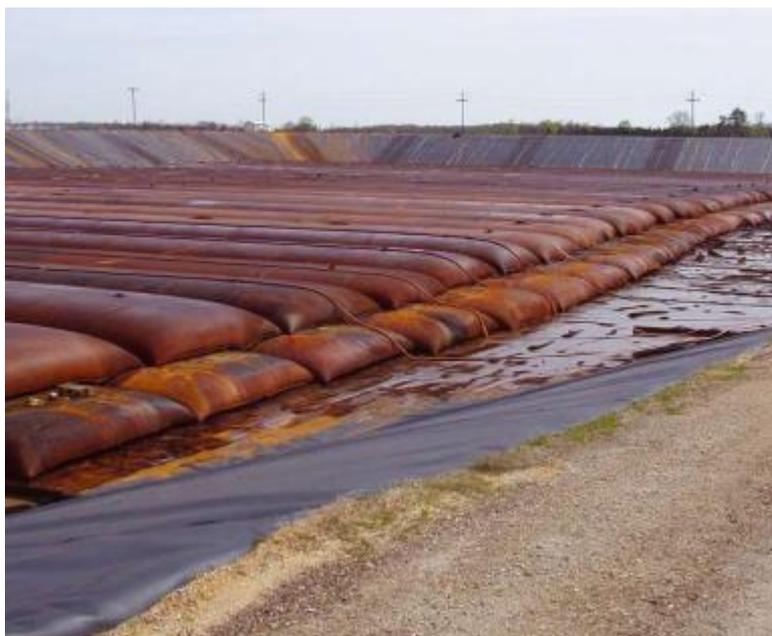
Рис. 5. Общий вид сложенных геотубов (Geotube) [25]
