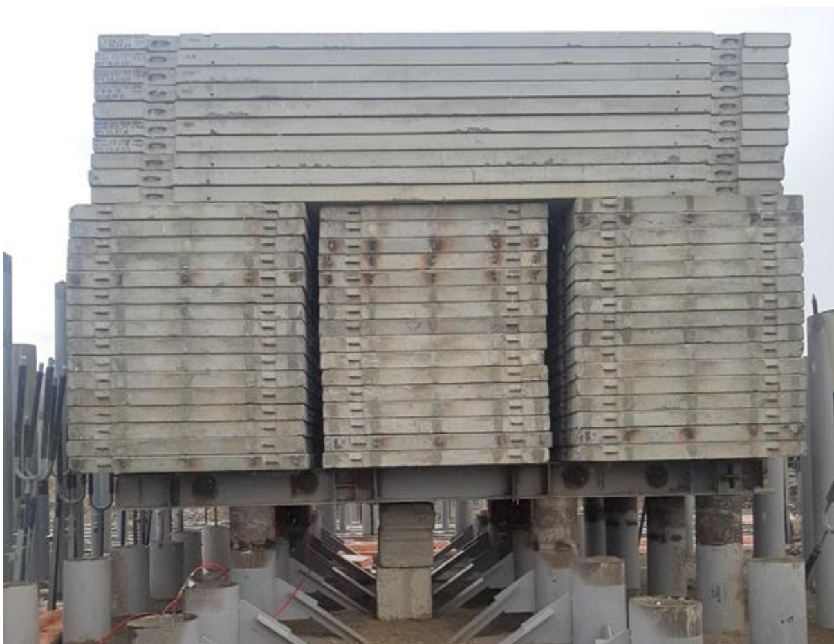
Рис. 2. Испытание грунтов сваей ускоренным методом
