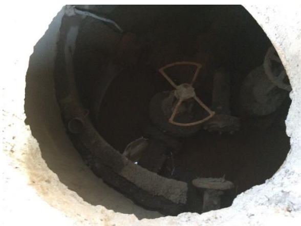
Рис. 5. Смещение колец колодца Fig. 5. Offset of the well rings
