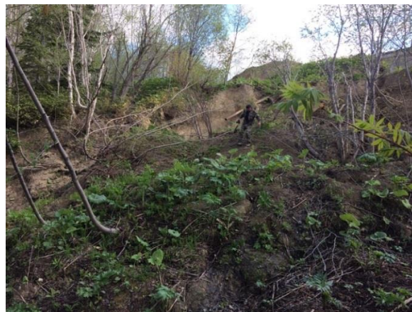
Рис. 2. Тело оползня Fig. 2. Landslide body
