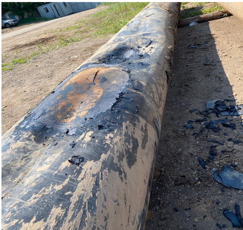
Рис. 1. Смятие газопровода вследствие образования льда в межтрубном пространстве Fig. 1. Crumpling of the gas pipeline due to the formation of ice in the inter-pipe space
