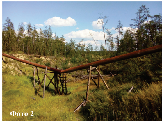
Рис. 2. Места и проявления на участке водовода «Сырдах–Борогонцы», угрожающие прогибом и конкретным механическим разломом: первое проявление (фото 1) – термоэрозионный овраг, второе проявление (фото 2) – термокарстовый провал
