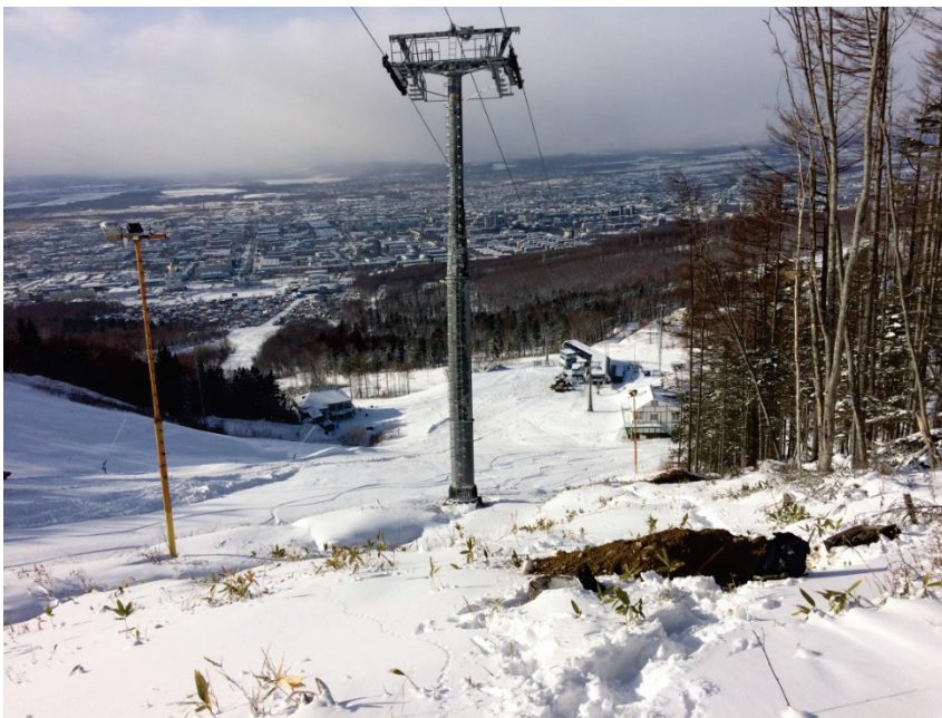
Рис. 4. Канатно-гондольная трасса «Запад»
