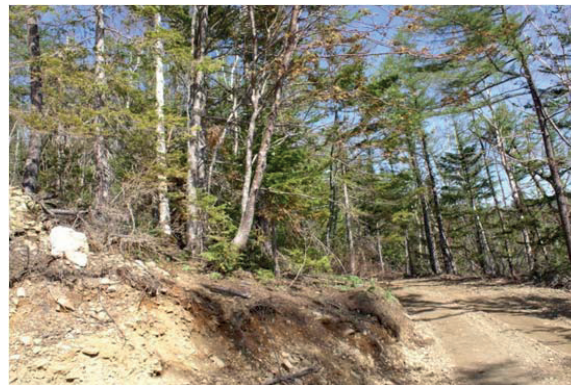
Рис. 4. Оползни гидродинамического разрушения
