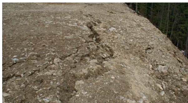
Рис. 9. Трещины оседания
